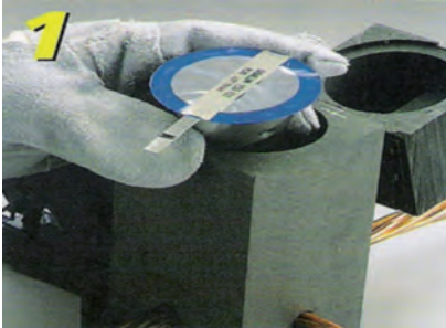
Adım1: Cadweld Plus paketi pota içine yerleştirilir. [kapak kullanılması gerekebilir.] Step 1: Insert CADWELD PLUS package into mold.
